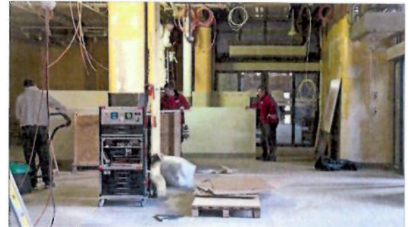
Noch sind die Umbauarbeiten im Gange. Sie werden alle termingerecht beendet sein.
